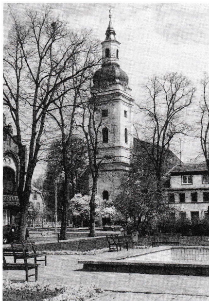
St. Trinitatiskirche in Genthin, Anfang der 90er Jahre nach der Sanierung
